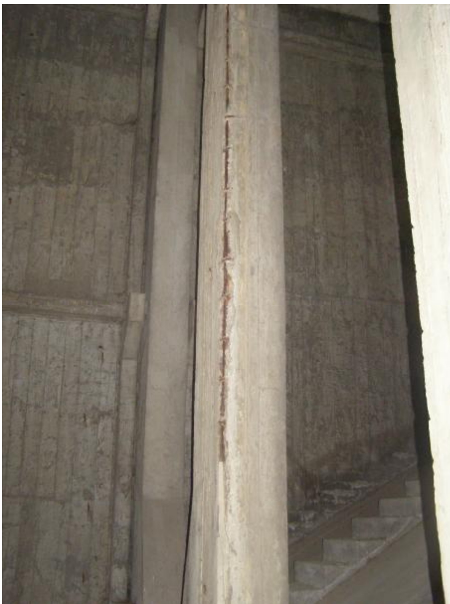
Schodiště na oblouku, odhalená výztuž sloupu
