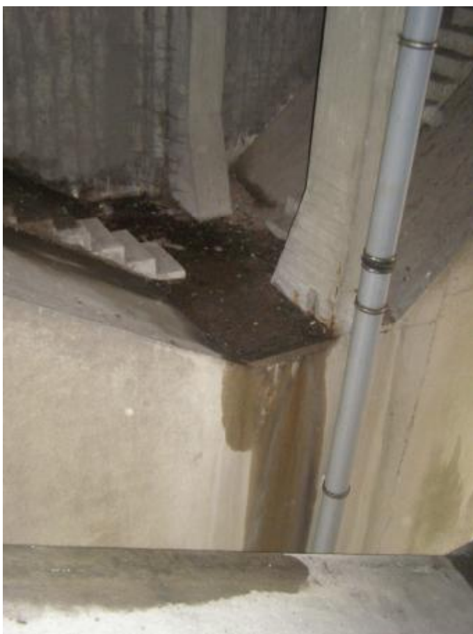
Nad pilířem- zatékání dilatací, nánosy trusu
