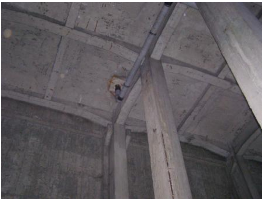
Podhled- odhalené třmínky, odhalená výztuž sloupu
