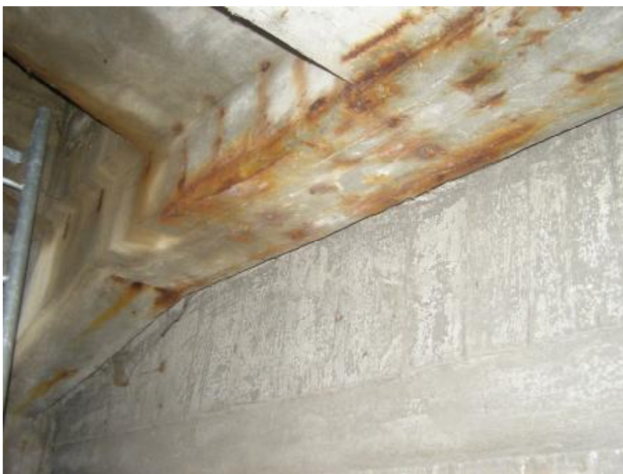
Trám u vlezu- degradace betonu od zatékání
